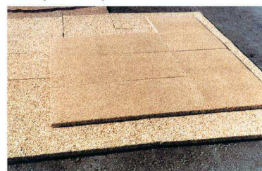
Messa in opera dei pannelli incrociati a doppio strato
